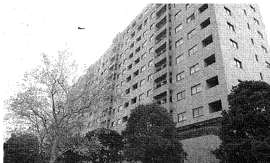
重厚な外観で、事務所ビルとも一体感のあるマンション
