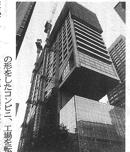
解体工事中の旧長銀本店ビル
